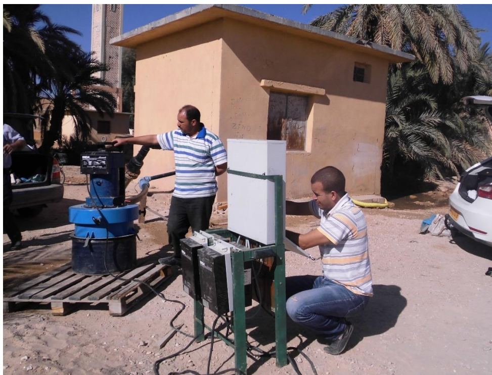
Figure 49 : Installation de la microcentrale hydroélectrique dans la commune d'E-Haouche - Wilaya de Biskra
