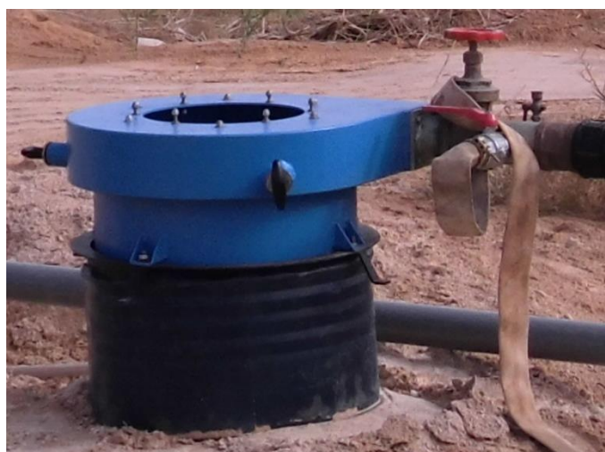
C. Bloc Turbine et le puit d'écoulement
