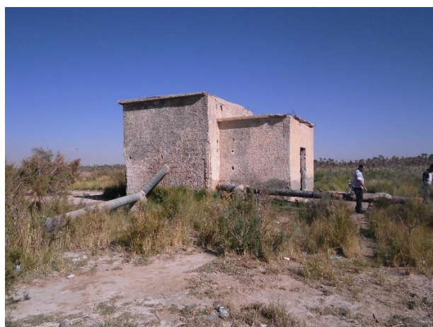
A- Abris de la tête de forage
